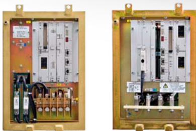
Inverter module and rectifier module
