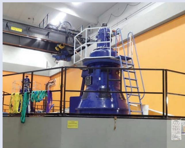
ljača generatora Sydkrafta. Opseg ugovora obuhvaća izradu proračuna za generator zbog povećanja snage turbine, obnovu dijelova generatora, rezervne dijelove, demontažu, montažu, ispitivanje i puštanje u pogon.
