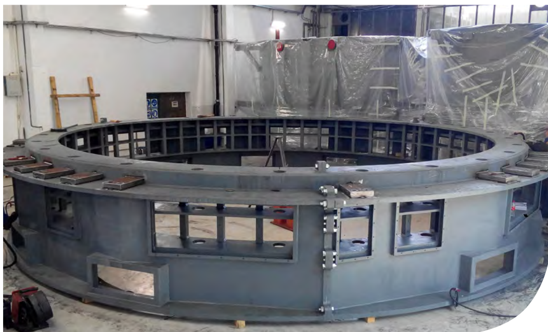
Zavarena konstrukcija – kućište statora hidrogenatora
