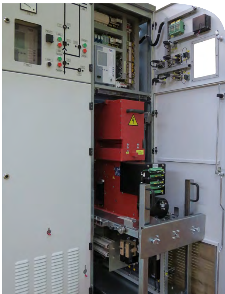
Izvlačivi odvod od 2600 A smješten u metalnom kućištu
