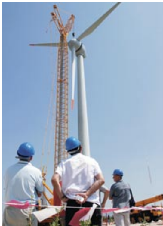
SLIKA 16: VJETROAGREGAT U IZGRADNJI
