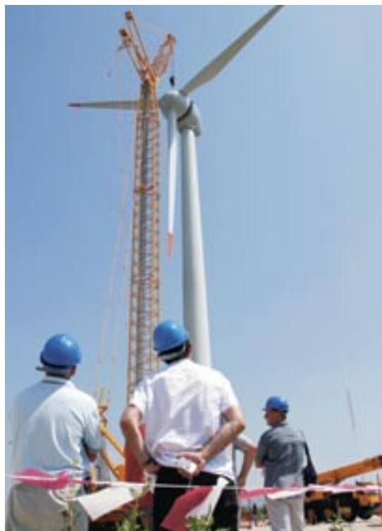
SLIKA 16: VJETROAGREGAT U IZGRADNJI
